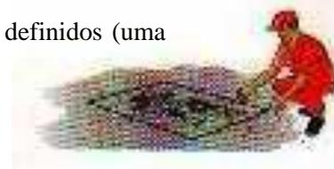
O objetivo é criar uma “ancoragem” para dificultar a saída da massa asfáltica do “buraco” e retirar o material oxidado (asfalto velho, material solto) das bordas do mesmo.
