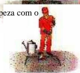
Com um regador, espalhar pouca água, suficiente para assentar a poeira e garantir a inexistência de pó solto, se necessário a varrição ou limpeza com o compressor deverá se estender sobre o pavimento existente, numa área maior que a prevista para a pintura de ligação.
