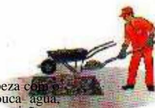
4- Efetuar a limpeza da área utilizando vassouras ou compressor. Na varrição ou limpeza com o compressor, retirar todo o pó que estiver solto. Com um regador, espalhar pouca água, suficiente para assentar a poeira e garantir a inexistência de pó solto, se necessário. A varrição ou limpeza com o compressor deverá se estender sobre o pavimento existente, numa área maior que a prevista para a pintura de ligação.
