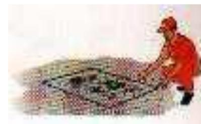
O objetivo é criar uma “ancoragem” para dificultar a saída da massa asfáltica do “buraco” e retirar o material oxidado (asfalto velho, material solto) das bordas do mesmo.
