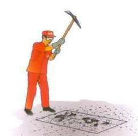
É fundamental que a face do recorte faça um ângulo de 90° com o revestimento existente.
