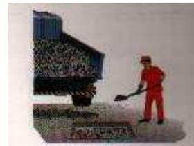
6- Executar a pintura de ligação sobre o material utilizado e nas paredes verticais da área recortada, utilizando emulsão asfáltica tipo RR -1C, pura, ou diluída no máximo com 20% (vinte por cento) de água, a critério da fiscalização. A emulsão deve cobrir toda a área que vai receber a massa asfáltica, sem se acumular em poças. Deve-se estender a pintura de ligação por 10 a 20 cm sobre o pavimento existente, isto é, para cada lado do buraco.
